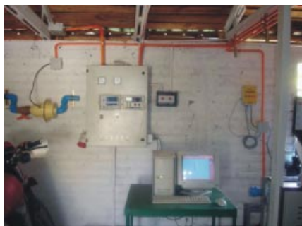
Foto 7. Equipo de monitoreo e inyección de ácido con control de pH y CE instalado en el experimento.
